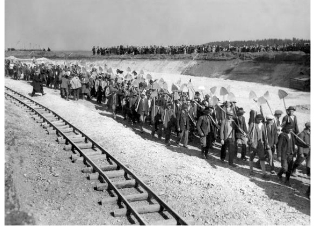
Unterhaching/Taufkirchen: Der Tag der 10000 Spaten am 21. März 1934, der Auftakt zum Bau der Autobahn München-Salzburg
